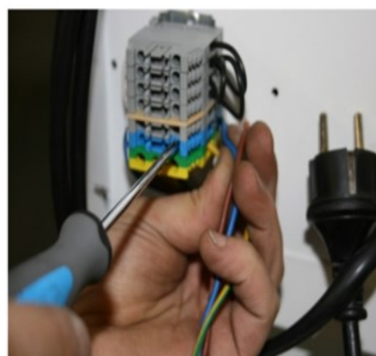
5. Tilslut strøm- og fjernhygostat-ledninger.
